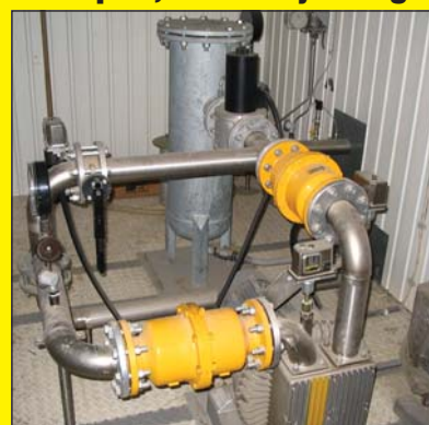
Čerpací stanice skládkového plynu (dmychadlo)
