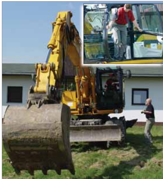
PRVNÍ VÝKOP: Kabinu bagru si před rokem při zahájení stavby aquaparku vyzkoušel i místostarosta Petr Cvik. Foto: Petr Pavelka
