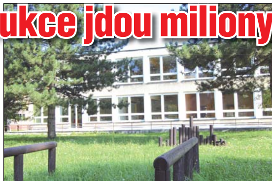
MŠ ANENSKÁ: Nová okna budově pomohly i esteticky.
