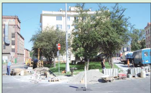
OPRAVA CHODNÍKŮ: V dolní části Třidy T. G. Masaryka ve Frýdku, za kruhovým objezdem, se provádí rekonstrukce chodníku. Do konce srpna zde budou vyměněny obrubníky a dlažba. V současnosti je třeba dávat pozor na zúžený jízdní pruh.
