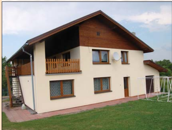
OPRAVENÁ BUDOVA: Zázemí pro sportovce i další místní aktivity.
