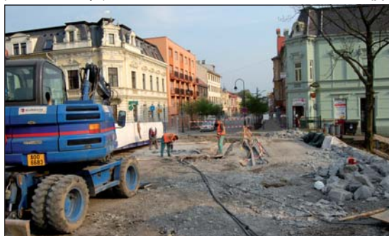
ŽELEZNIČNÍ MOST: Občané rekonstrukci pozorně sledují.
