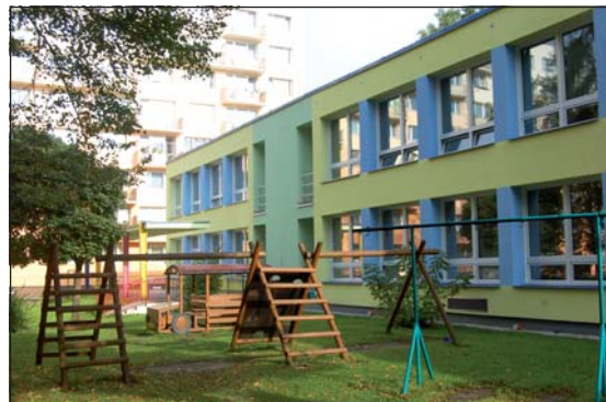
REKONSTRUOVANÁ BUDOVA MŠ: Odloučené pracoviště 4. ZŠ. Foto: Petr Pavelka
