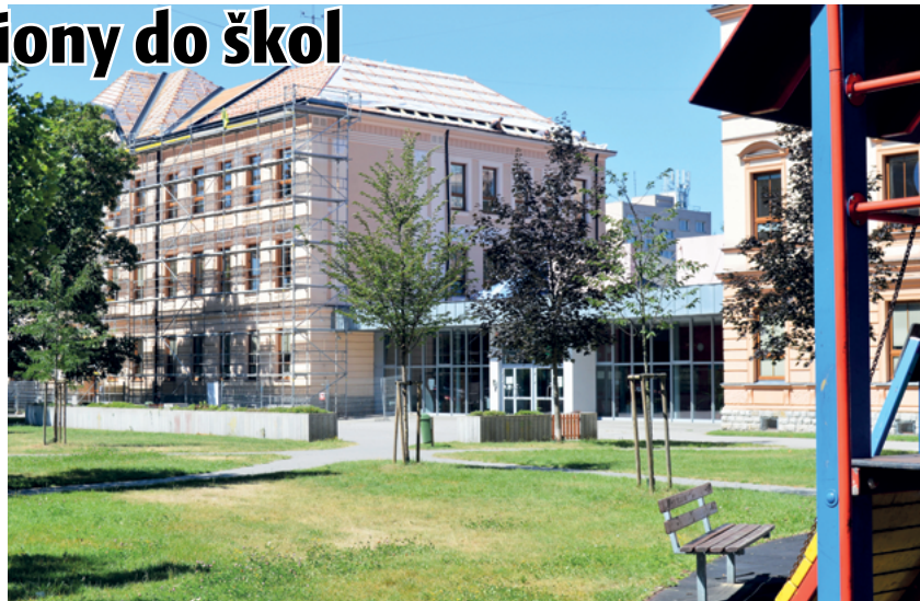
4. ZŠ: Oprava střechy.
