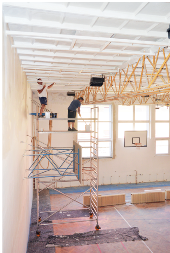
6. ZŠ: Rekonstrukce tělocvičny.
