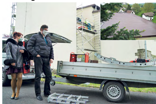
ZBROJNICE V LÍSKOVCI: Po vylepšení energetické náročnosti objektu došlo i na střechu. Foto: Petr Pavelka
