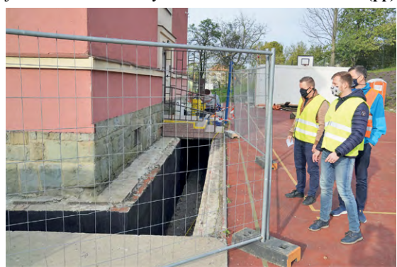
ZŠ SKALICE: Objekt získává novou hydroizolaci spodní stavby. Foto: Petr Pavelka
