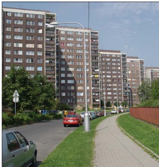
NOVODVORSKÁ: Další parkovací místa vzniknou na sídlišti Slezská.
