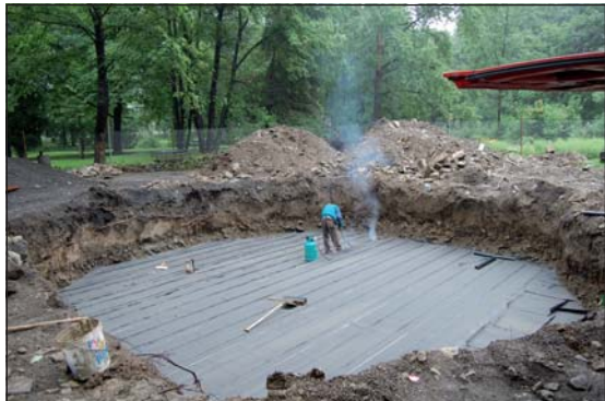
STAVENIŠTĚ V PARKU: Nový altán už se začal budovat.
