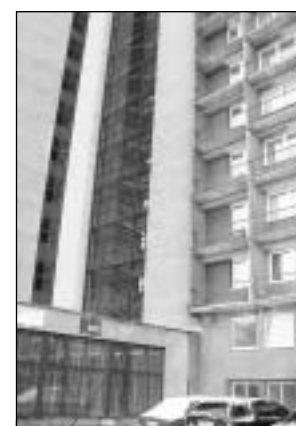
Bývalý hotelový dům Koloredov prošel rozsáhlou rekonstrukcí. V závěru roku 2001 zde vzniklo 112 nových, tzv. startovacích bytů, 2 patra městské ubytovny a 4 patra nebytových prostor určených k podnikání.
