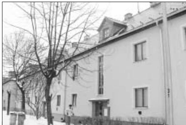
Obecní domy na Nové Osadě dostaly v loňském roce zcela nový kabát. Město uhradilo opravu střech, výměnu oken a dveří a novou fasádu včetně zateplení. FOTO: Jana Alžběta Čtvrtková
