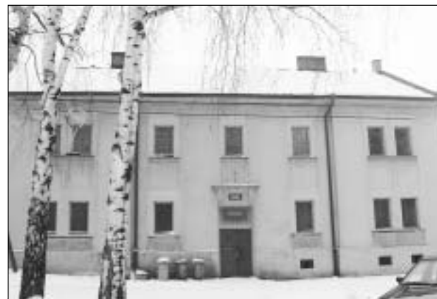
V místeckém Přístřeší byly vloni nahrazeny luxfery dřevěnými okny, což zabezpečuje řádné větrání a dostatek světla v objektu.
