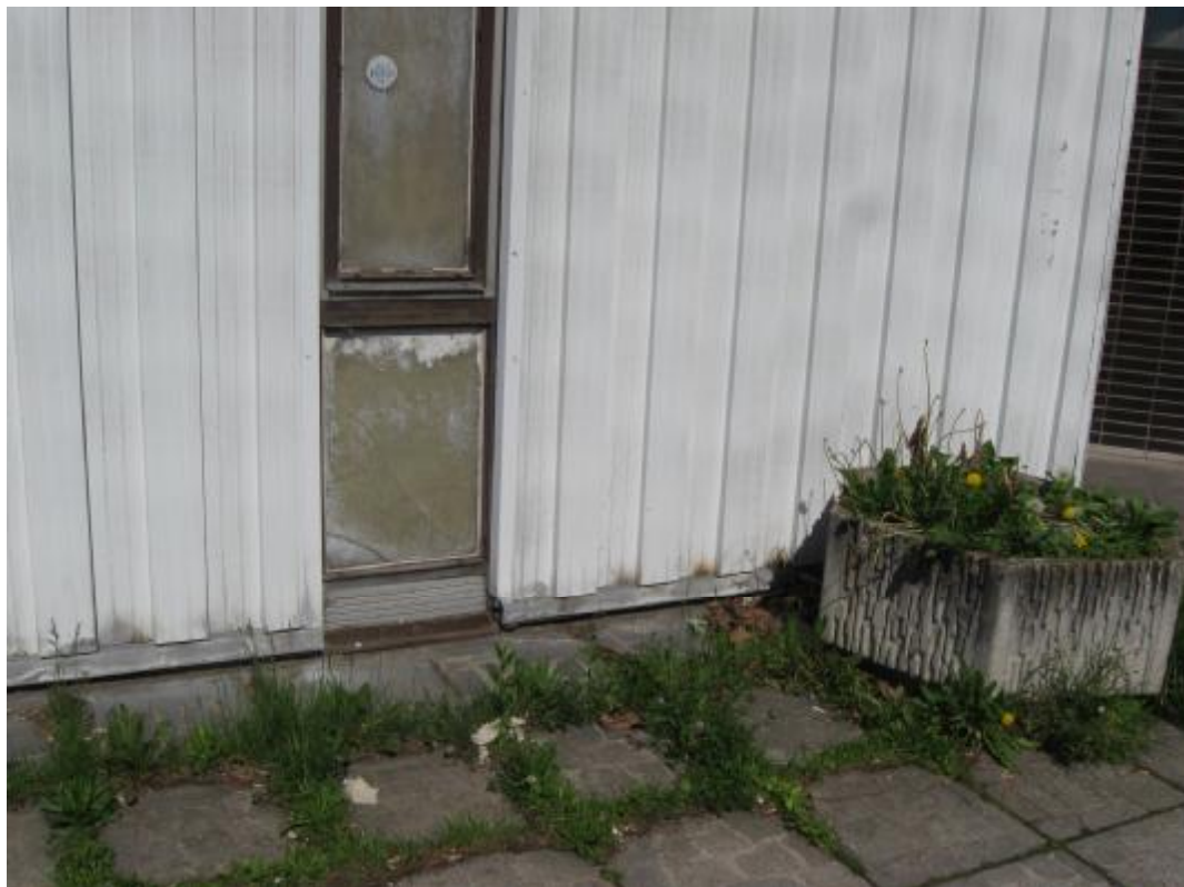
Okna osazená ve fasádě
