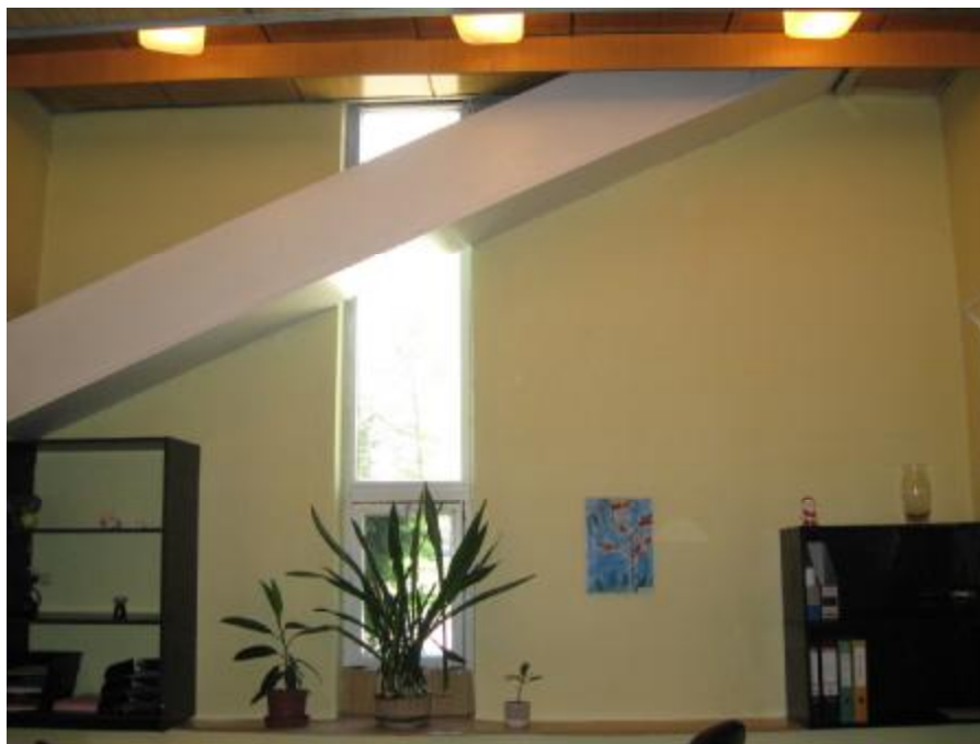
Stěna v kanceláři se zakrytým ocelovým prvkem
