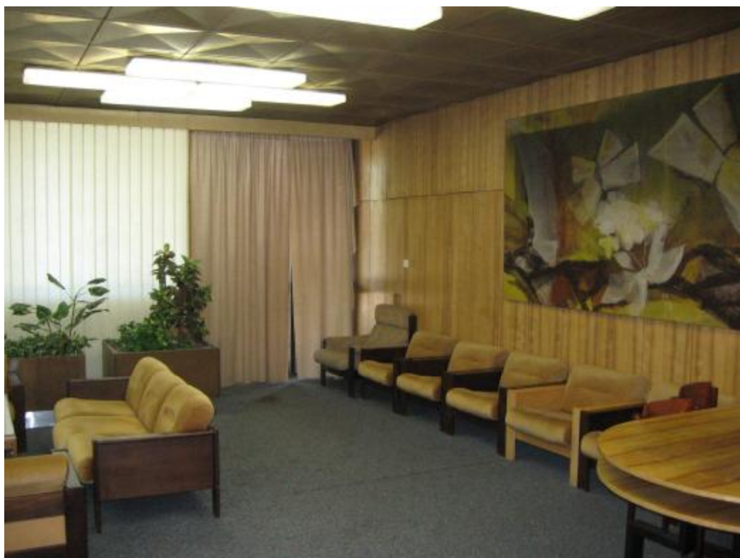
VIP – koberec, dřevěný obklad stěn, kazetový verzalitový podhled
