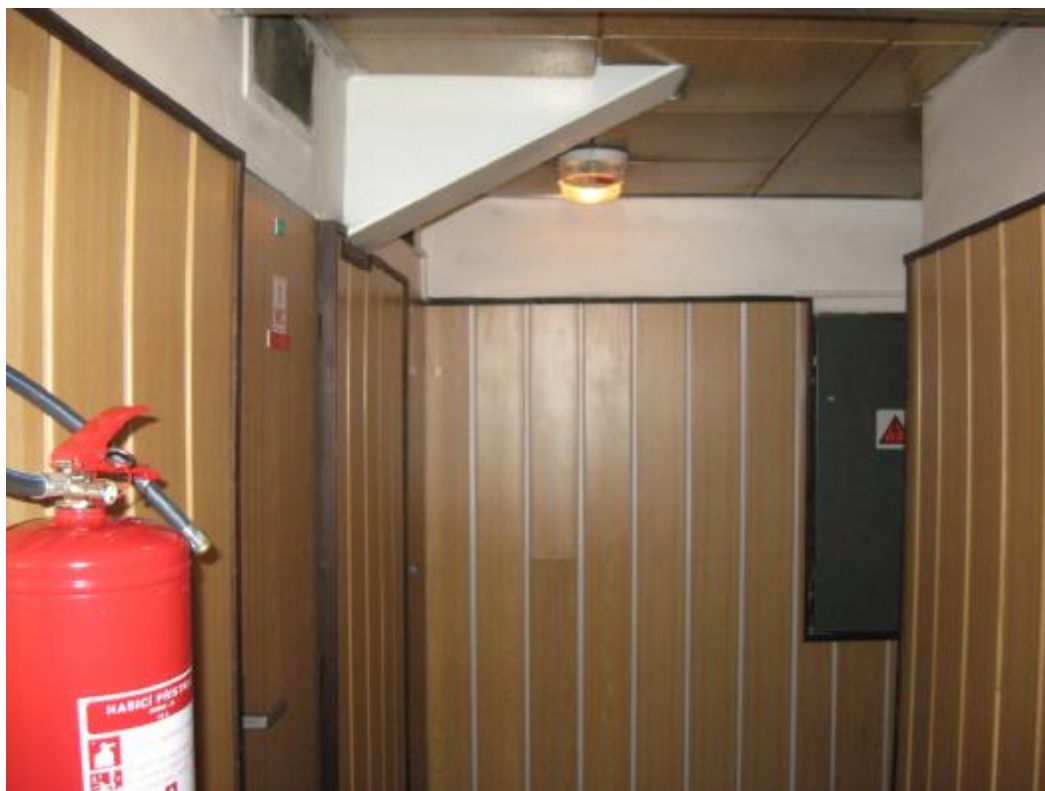
Chodba – koberec, verzalitový obklad stěn, kazetový verzalitový podhled
