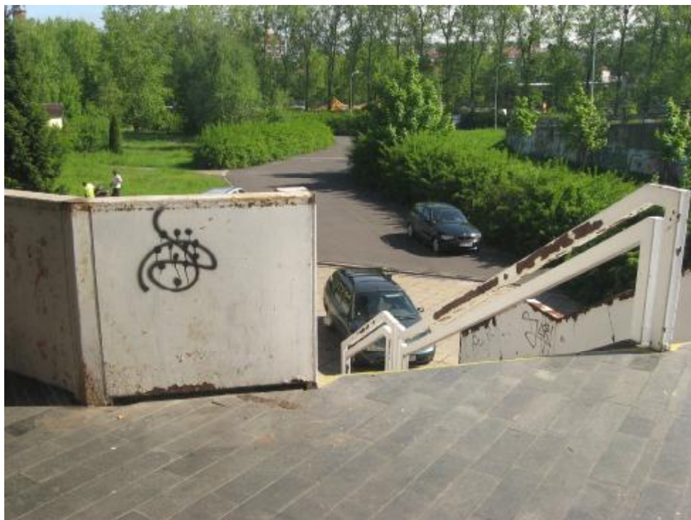
Terasa včetně schodiště
