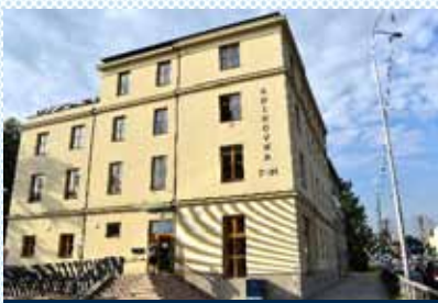
Rekonstrukce místecké pobočky knihovny
