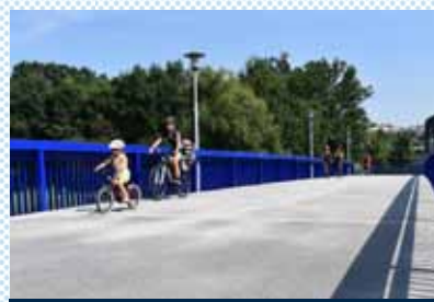
Oprava modré lávky přes řeku Ostravici
