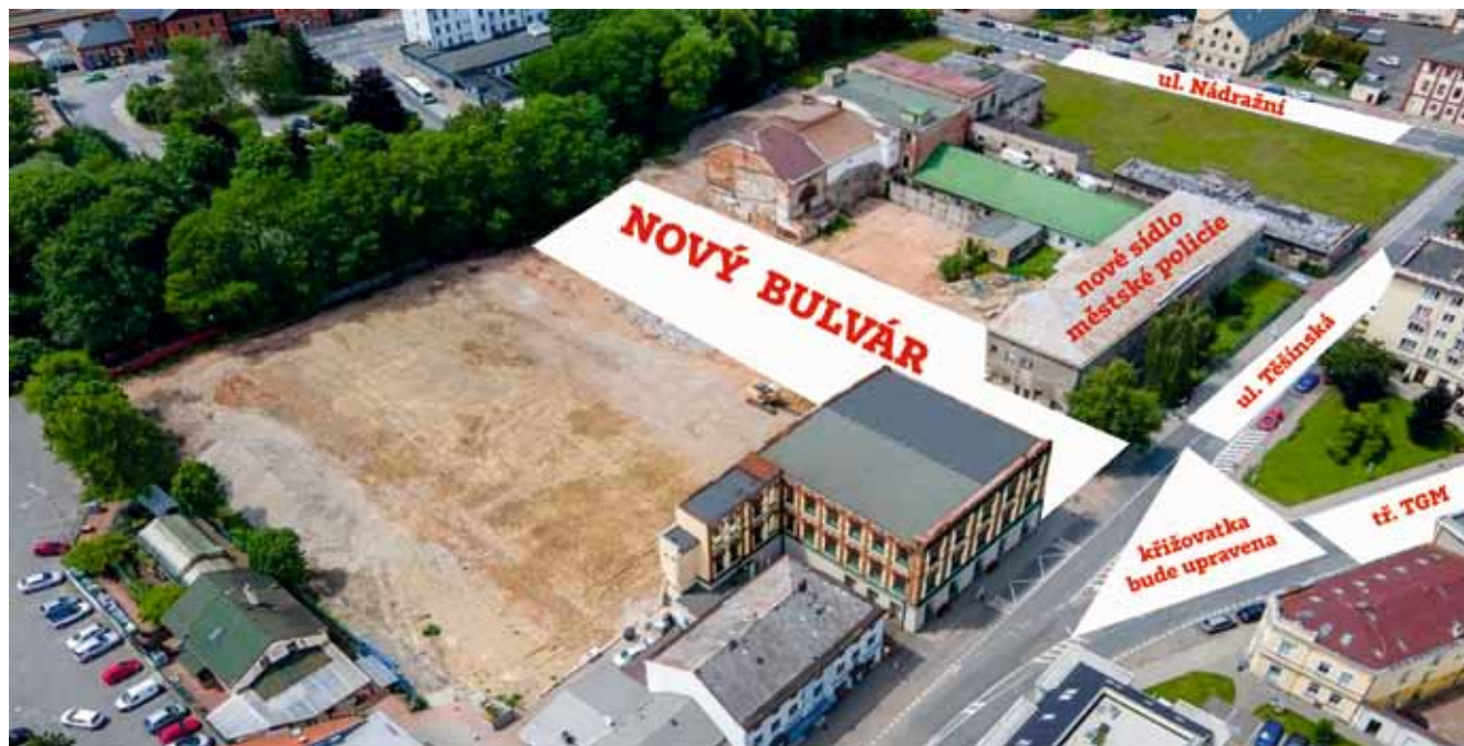
LETECKÝ POHLED NA NOVĚ VZNIKAJÍCÍ BULVÁR S REKONSTRUOVANOU BUDOVOU SÍDLA MĚSTSKÉ POLICIE. FOTO: SLEZAN
