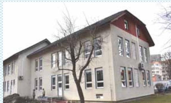
Zateplení budovy a výměna oken v IC Žirafa ve Fibichově ul.
