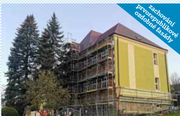
Zateplení budovy ZŠ a MŠ ve Skalici
