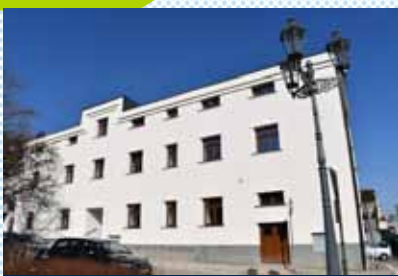
Rekonstrukce budovy v ul. Radniční 13
