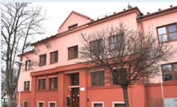
Rekonstrukce Domova pro seniory FM v ul. Školské
