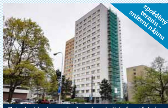
Zateplení budovy, výměna oken, balkonů a střešní krytiny v ul. Anenské
