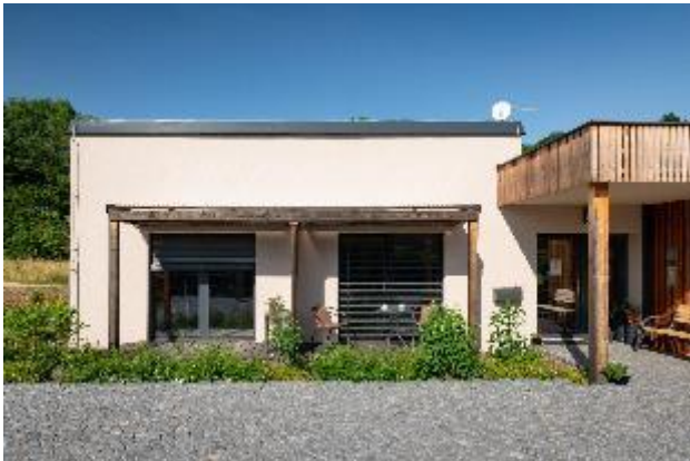
Domov Podhradí chrání seniory před horkem. Vnější žaluzie a pergola brání slunečním paprskům, aby se dostaly dovnitř a přeměnily se na teplo. Foto: Nadace Partnerství – Adapterra Awards, Vojta Herout
