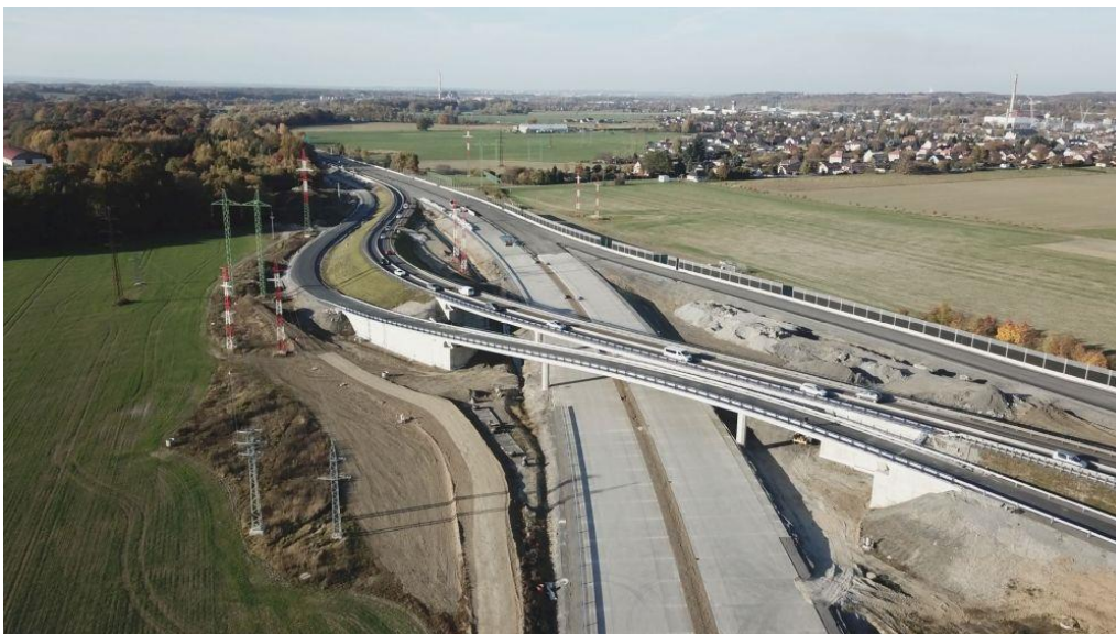
Obrázek 24: Stavba obchvatu Frýdku-Místku v roce 2021 - napojení D48-D56 (Zdroj: www.msstavby.cz )
