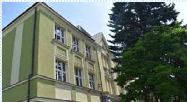
Zateplení budovy a nová fasáda na ZŠ a MŠ ve Skalici
