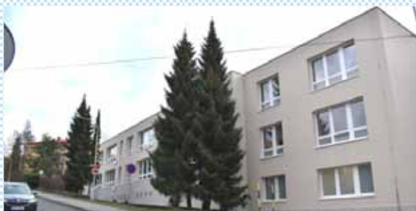
Zateplení přístavby u 1. ZŠ v ul. Husově
