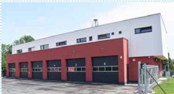
Rekonstrukce hasičské zbrojnice v ul. Střelníční
