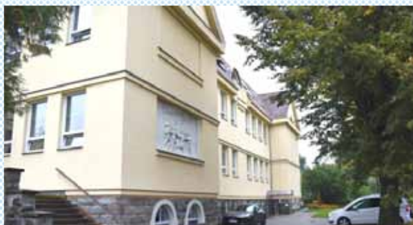
Hydroizolace ZŠ v Lískovci
