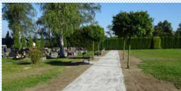
Opravy a budování chodníků (např. na hřbitově v Lískovci)
