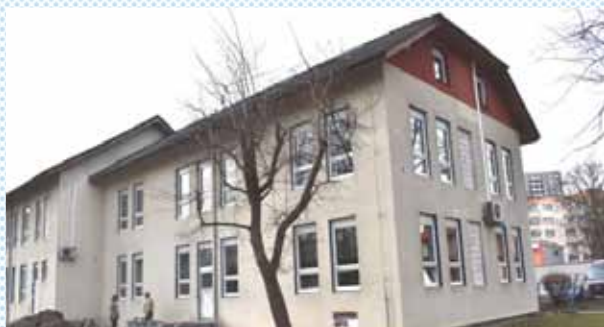
Zateplení budovy a výměna oken v IC Žirafa
