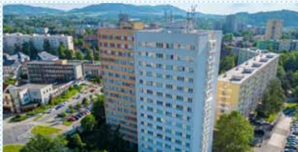
Rekonstrukce budovy – zateplení, výměna oken, balkónů a střešní krytiny v ul. Anenské
