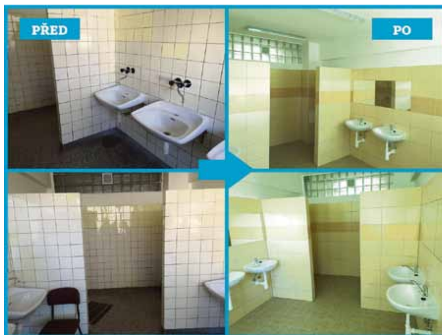
SROVNÁNÍ STAVU PŘED A PO OPRAVĚ UMÝVÁREN.
