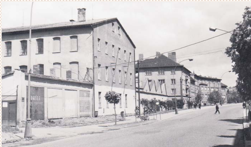
↑ BÝVALÁ CZAJANKOVA KASÁRNA V DOBĚ PŘED VÝSTAVBOU PRŮTAHU FRÝDKEM-MÍSTKEM V 70. LETECH MINULÉHO STOLETÍ.
