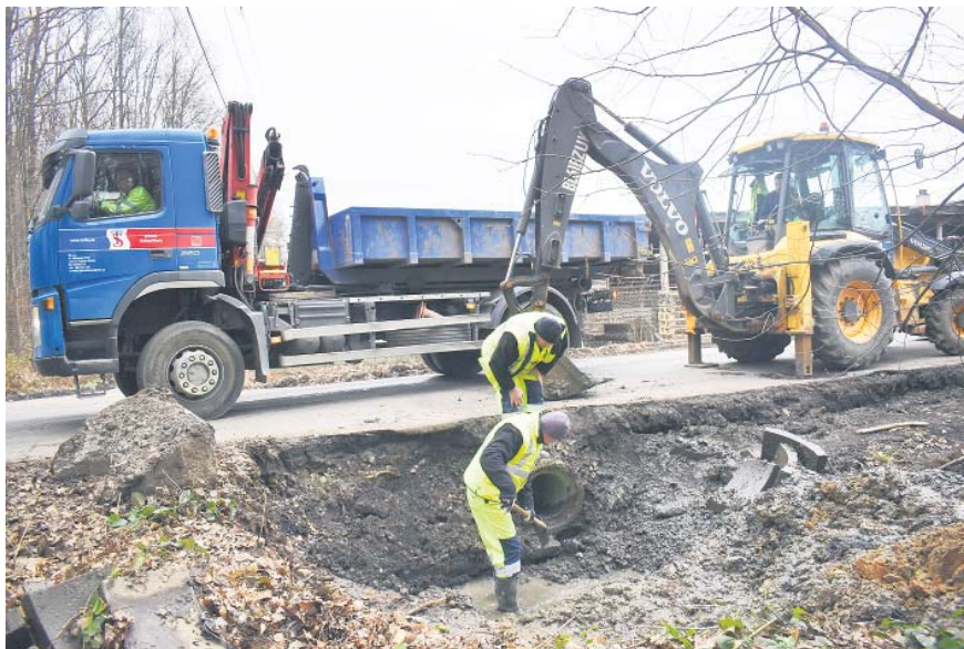
VÝSTAVBA ZASTÁVKY V PANSKÝCH NOVÝCH DVORECH. FOTO: RENÉ STEJSKAL
