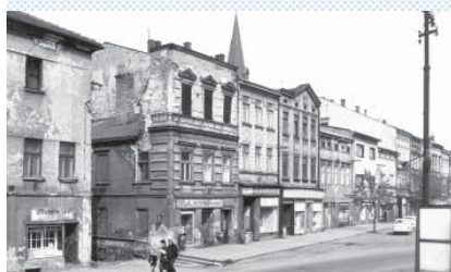
↓ Z DOMŮ NA MÍSTECKÉM NÁMĚSTÍ OPADÁVALY KUSY FASÁD.
