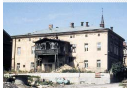
↓ DŮM NA ROHU TĚŠÍNSKÉ A RADNIČNÍ ULICE.
