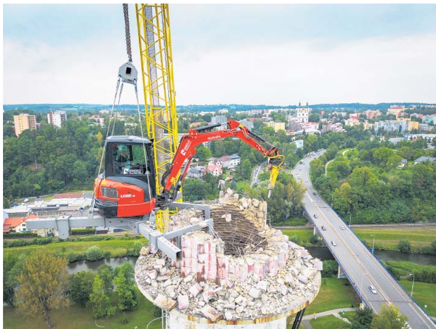
BAGRISTA ODSHORA POSTUPNĚ ODLAMOVAL KUSY KOMÍNU. FOTO: LIBOR SOLAŘ
