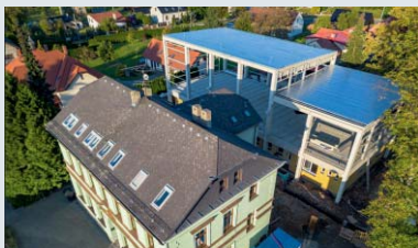
Výstavba nové tělocvičny u ZŠ /Chlebovice/
