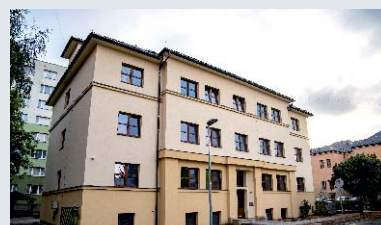
Rekonstrukce Domova pro seniory /ul. Skolská/
