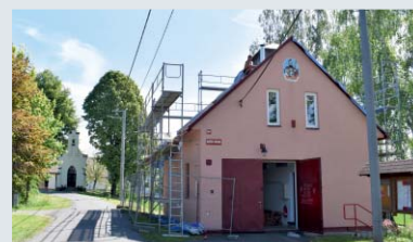
Oprava hasičské zbrojnice /Panské Nové Dvory/
