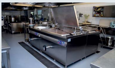
Rekonstrukce školní kuchyně /ul. E. Krásnohorská/
