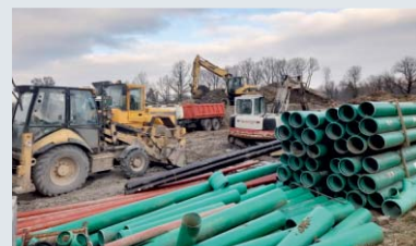
Odkanalizování Skalice, Chlebovic, Zelinkovic-Lysůvek, Lískovec-Gaj.
