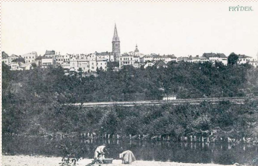
↓ ZPEVNĚNÍ FRÝDECKÉHO BŘEHU ŘEKY OSTRAVICE KŮLOVOU KONSTRUKCÍ, V POZADÍ DOMY NA ULICI HASIČSKÁ A NA ALBRECHTOVĚ NÁMĚSTÍ, ROK 1906.
