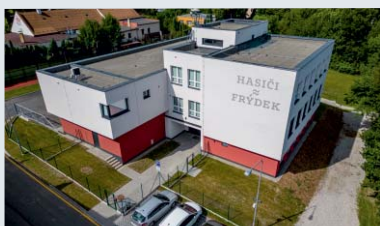
Rekonstrukce hasičské zbrojnice pro SDH /ul. Střelnická/
