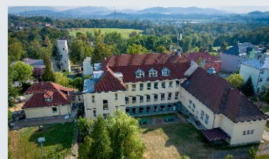
Zajištění hydroizolace budovy ZŠ /Lískovec/
