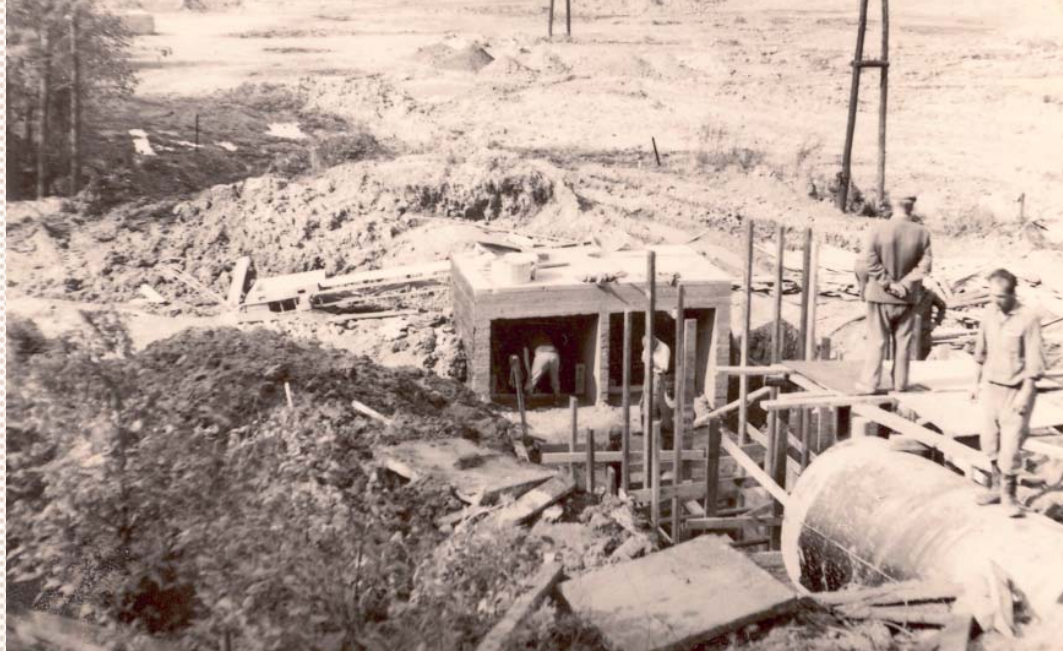
↑ ZATRUBNĚNÍ ČÁSTI TOVÁRNÍHO NÁHONU V OBLASTI DNEŠNÍHO TJ SLEZAN VE FRÝDKU V LETECH 1968–1969.
