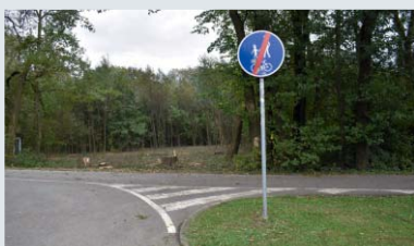
Výstavba cyklostezky Olešná - Palkovice
