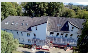
Zateplení budovy a výměna oken v IC Zírafa /ul. Fibichova/
