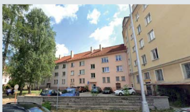
Budování kanalizace byt. domů /tř. T. G. Masaryka/
