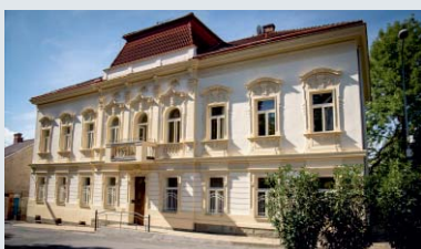
Oprava fasády Domu s pečovatelskou službou /ul. Těšínská/
