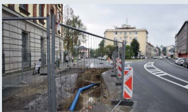
Rekonstrukce křižovatky /ul. Těšínská a ul. Slezská/
