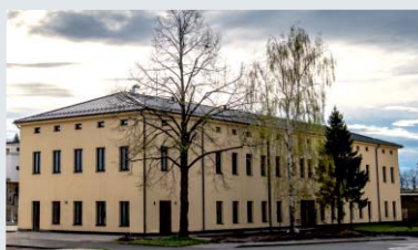
Rekonstrukce budovy, nové sídlo městské policie /ul. Těšínská/
