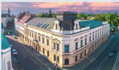
Rekonstrukce Národního domu /ul. Palackého/
