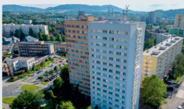
Rekonstrukce bytového domu /ul. Anenská/
