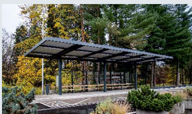
Rekonstrukce autobus. zastávky Polit. obětí /bývalé AS/
