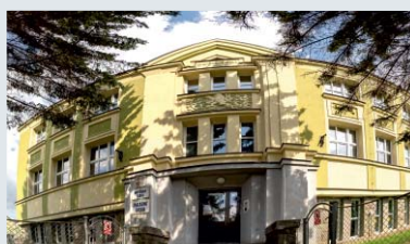
Rekonstrukce budovy ZŠ a MŠ /Skalice/
