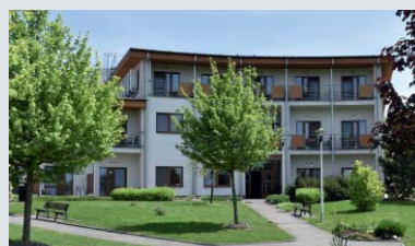
Oprava hydroizolace v hospici /I. J. Pešíny/
