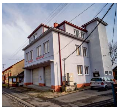
↑ ZBROJNICE V ZELINKOVICÍCH BYLA OPRAVENA VČETNĚ ZŘÍZENÍ KANALIZAČNÍ PŘÍPOJKY ZA 2,1 MIL. KČ.
