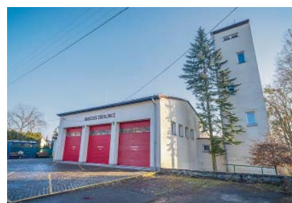
↑ OPRAVY ZBROJNICE V LÍSKOVCI PROBĚHLY V NĚKOLIKA ETAPÁCH, CELKOVÁ ČÁSTKA ČINÍ 2,7 MIL. KČ.
