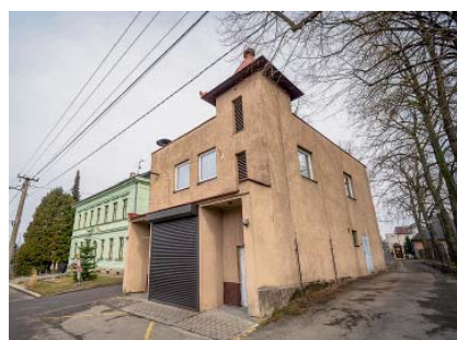
↑ OPRAVA ZBROJNICE V CHLEBOVICÍCH STÁLA NECELE DVA MILIONY KORUN.
