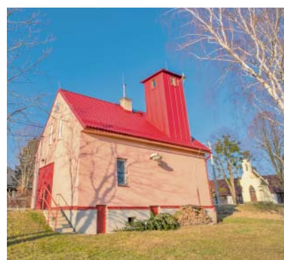
↑ VÝMĚNA STŘEŠNÍ KRYTINY A KROVŮ VE ZBROJNICI NA PANSKÝCH NOVÝCH DVORECH STÁLA 1,5 MIL. KČ.
