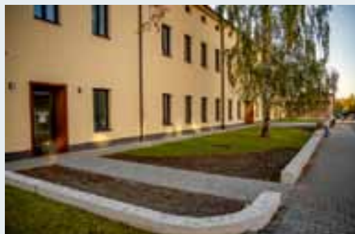
Rekonstrukce budovy MP /ul. Tešínská/
