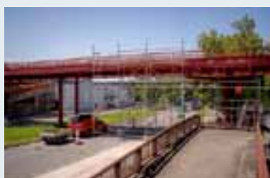
Rekonstrukce „červené lávky“ /ul. Revoluční/
