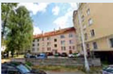
Kanalizace bytových domů /ul. Těšínská/
