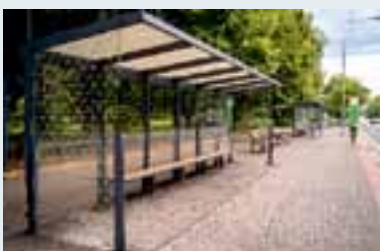
Autobusové zastávky /ul. Anenská/
