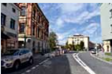
Oprava křižovatky /ul. Těšínská a ul. Slezská/
