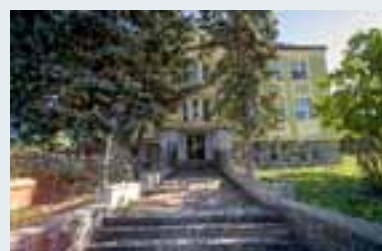
Rekonstrukce hlavního vstupu a chodníku u ZŠ /Skalice/
