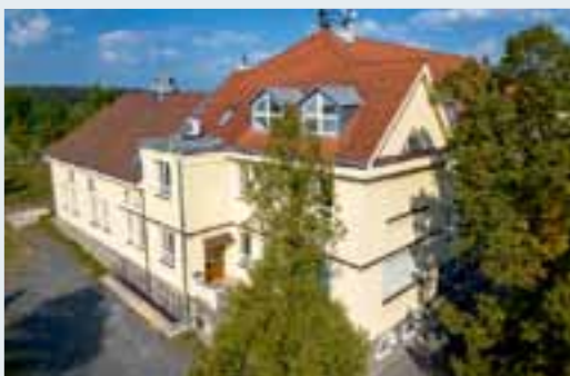
Hydroizolace v ZŠ /Lískovec/
