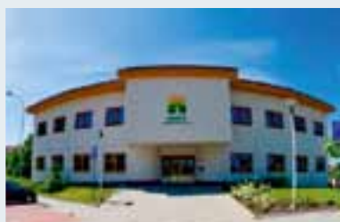
Hydroizolace budovy hospice /ul. I. J. Pešiny/
