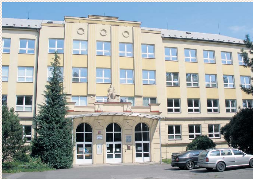
↑ BUDOVA 5. ZÁKLADNÍ ŠKOLY
