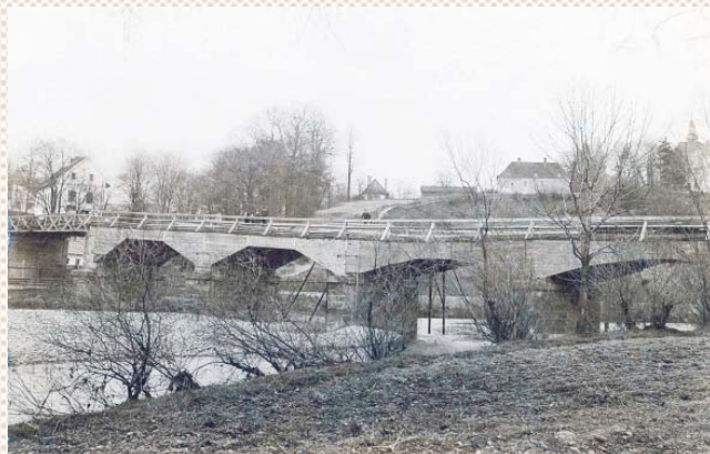
↑ PONIČENÝ DŘEVĚNÝ MOST PO POVODNI V ROCE 1880.
