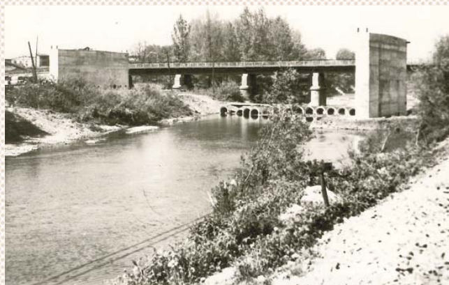
↑ VÝSTAVBA NOVÉHO KOLOREDOVSKÉHO MOSTU V ROCE 1984.
