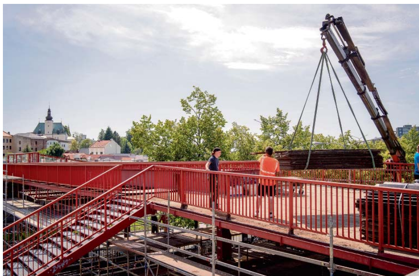
↑ SNÍMEK ZACHYCUJE VÝMĚNU MOSTOVKY NA ENERGOLÁVCE. FOTO: LIBOR SOLAŘ ← OPRAVENÁ LÁVKA S ANTRACITOVÝM NÁTĚREM. FOTO: RENÉ STEJSKAL
