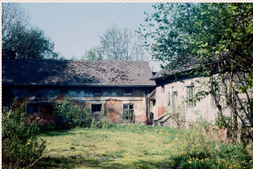
↑ BUDOVA MLÝNU V LÍSKOVCI.
