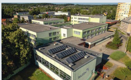
Fotovoltaika na budově 11. ZŠ /ul. J. z Poděbrad/
