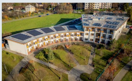
Fotovoltaika a hydroizolace na budově hospice /ul. I. J. Pešiny/
