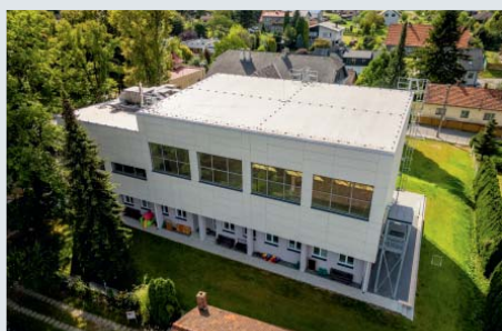
Tělocvična u ZŠ /Chlebovice/
