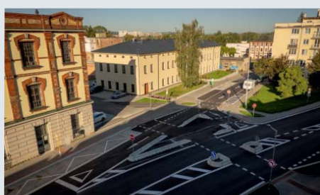
Úprava komunikace a křižovatky /ul. Těšínská/
