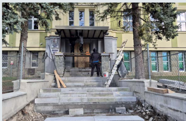
Oprava vstupu a chodníku u ZŠ /Skalice/
