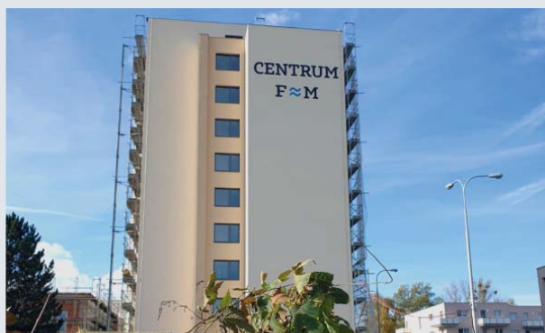
Rekonstrukce bývalého hotelu Centrum, realizuje Distep a.s.
