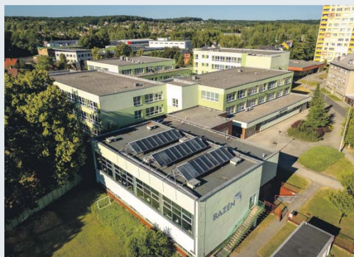
Fotovoltaika na střeše /11. ZŠ/
