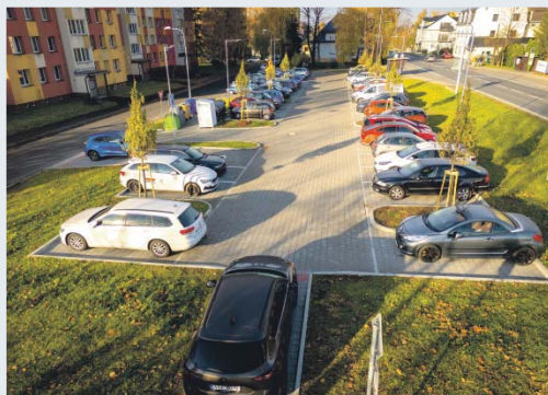
Rekonstrukce parkoviště /naproti Židov. hřbit./
