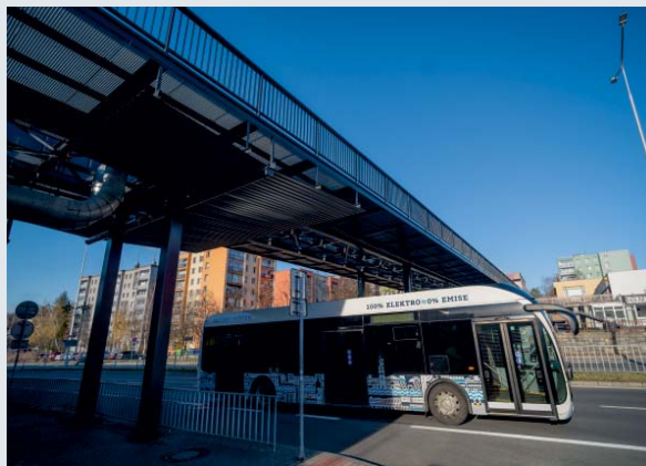
Oprava „červené lávky“
