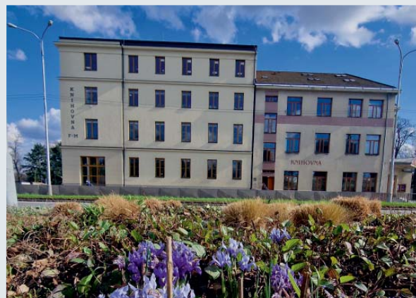
Zrekonstruovaná městská knihovna, pobočka v Místku
