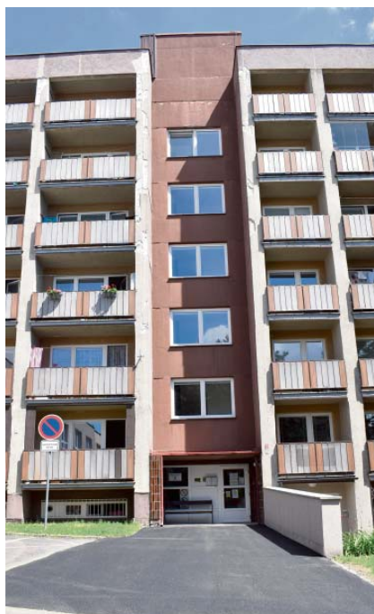
↑ NOVÝ POVRCH CHODNÍKU U DOMOVA V LÍSKOVECKÉ ULICI. FOTO: RENÉ STEJSKAL
