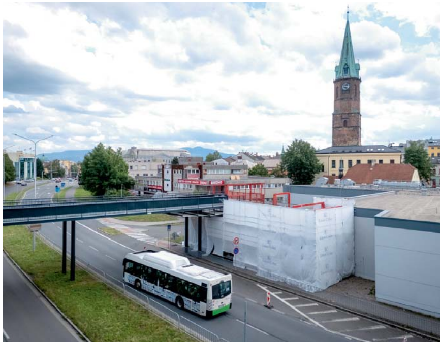
OPRAVOVANÁ LÁVKA PŘES REVOLUČNÍ ULICI. FOTO: LIBOR SOLAŘ
