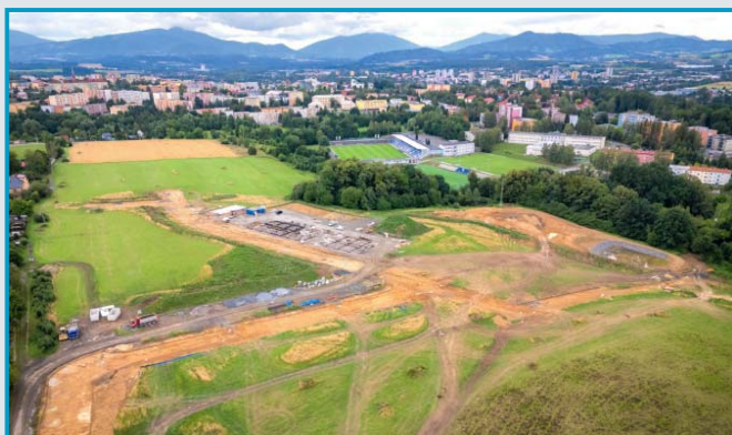
Výstavba inženýr. sítí v části Berlín II.
