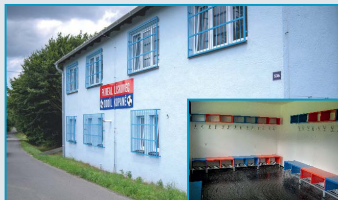
Oprava zázemí fotbal. hřiště v Lískovci
