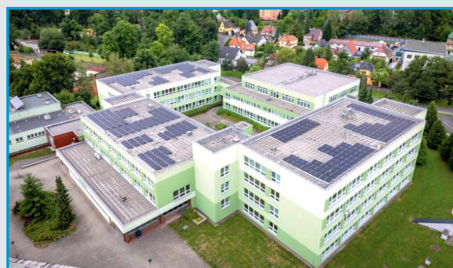
Instalace fotovoltaiky na 11. ZŠ
