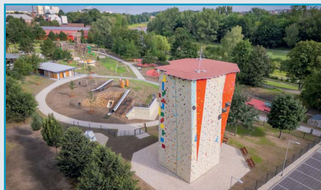
Výstavba obří lezecké stěny v novém volnočasovém areálu RIVKA≈PARK
