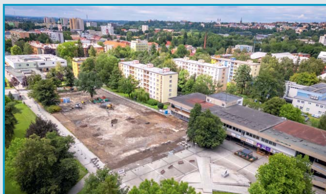
Budování parkoviště na Riviéře
