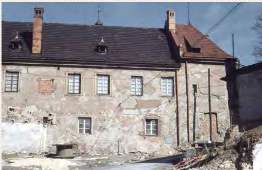
↑ V JIHOVÝCHODNÍM KŘÍDLE FRÝDECKÉHO ZÁMKU SE ZACHOVALA PŮVODNÍ GOTICKÁ OBVODOVÁ HRADBA. STAV PŘI OPRAVÁCH V ROCE 1988
