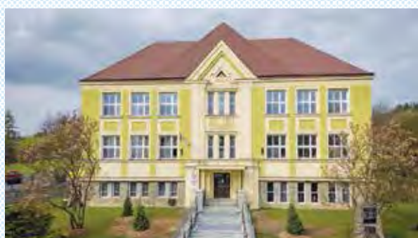
↑ Rekonstrukce základní školy ve Skalici
